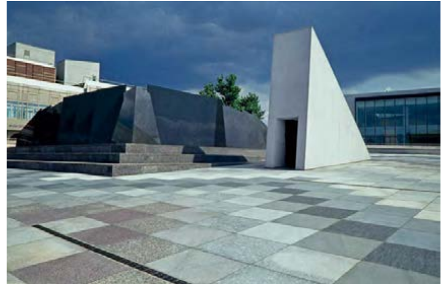
PIAZZETTA, AUSSICHTSPLATTFORM UND GARAGEN-AUSGANG, 1984-1992, MAX. HÖHE 7 M, GRANIT, KULTURFORUM AM KEMPERPLATZ PIAZZETTA, VIEWING PLATFORM AND EXIT OF THE GARAGES, 1984-1992, 7 M HIGH, GRANITE, CULTURAL FORUM ON KEMPERPLATZ
